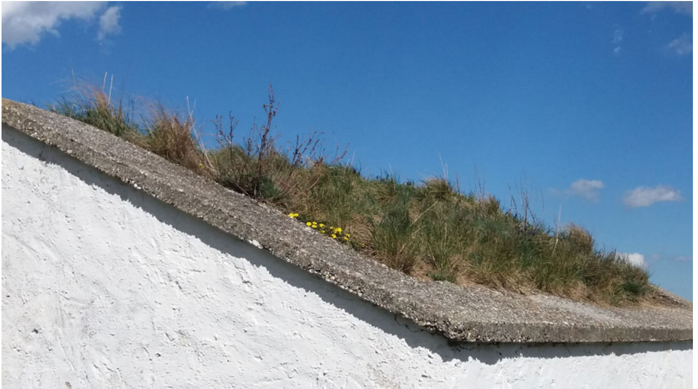
Das Dach der Hütelhütte in Stoitzendorf © M. Gross
