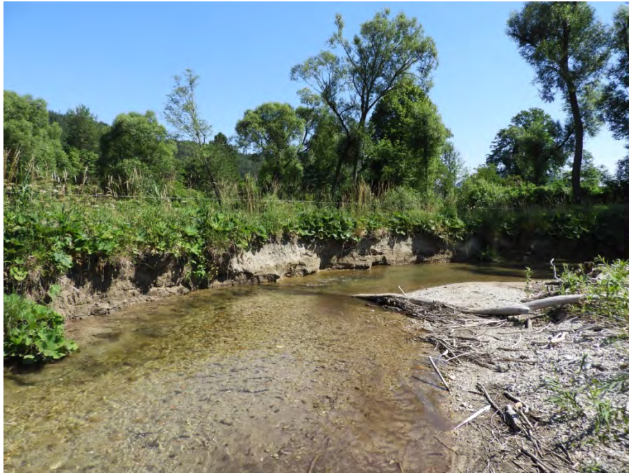
Abb. 15: Bereich 2 der Untersuchungstrecke an der Piesting, Blick flussab. Umströmte Insel (rechts), Ausprägung eines Anbruchufers am Prallhang; verringerte Strömungsgeschwindigkeit und Ablagerung von feinerem Substrat (Sand, Detritus) am Gleithang. 29.6.2019; Foto: A. Ch.
