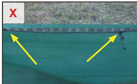
Die Spannschnur muss min. alle 5cm in die Laschen des Zaunes gefädelt werden. Zu große Abstände führen zum Ausreißen der Zaunlaschen. Die Spannschnur muss knotenfrei sein. Nur so ist das gute Spannen jeder Zaunbahn möglich.
