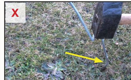
Bei hartem Untergrund ist ein Vorbohren der Steherlöcher sinnvoll. Nur dadurch ist gewährleistet, dass die Steher nicht verbogen werden und die Steheröse auf der Höhe der Zaunoberkante ist.
