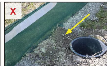
Die Fangkübel (z.B. Doppelkübel) müssen bündig zum Zaun eingegraben werden. Nur so kann verhindert werden, dass Amphibien am Kübel vorbeiwandern und auf die Straße gelangen. Auch dürfen kein Spalten zwischen Kübel und Erdreich verbleiben über die Amphibien unter die Kübel gelangen können.
