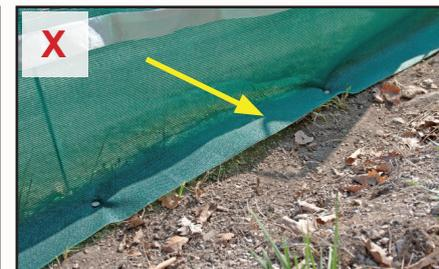
Den Zaun eingraben oder zusätzlich zu den Erdnägeln (alle 1m) mit z.B. Riesel oder Erde komplett bedecken. Nur dadurch ist sichergestellt, dass Amphibien den Zaun nicht unterklettern oder der Zaununterteil ausgerissen und verweht wird.
