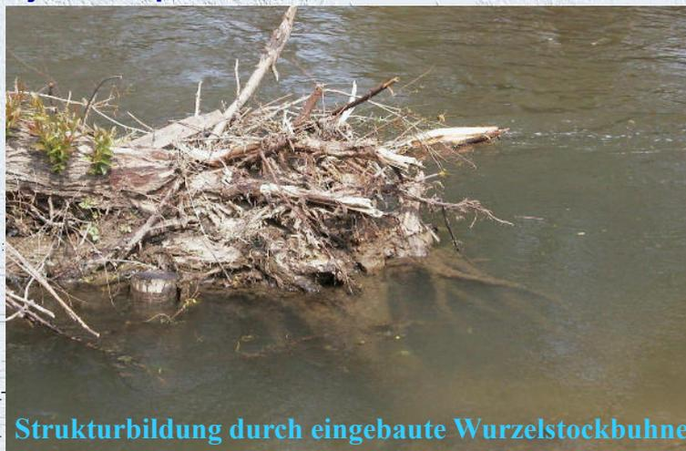
Strukturbildung durch eingebaute Wurzelstockbühne
