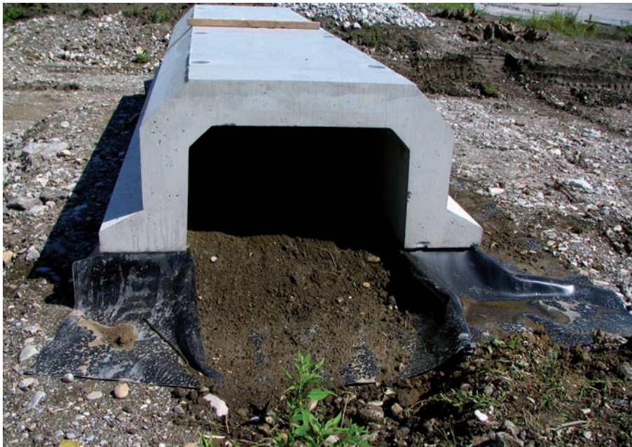
Abb. 6: Stelztunnel mit Foliendichtung (Foto: M. KYEK)
