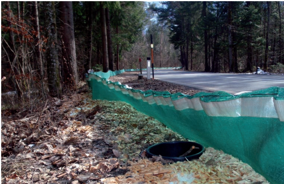
Abb. 2: Beispiel eines mit Spannschnur errichteten und mit Hackschnitzeln hinterfüllten Schutzzaunes (L114 Großmainer Landesstraße). Derartige Zäune sind im Land Salzburg seit ca. 20 Jahren im Einsatz (Foto: M. KYEK)
