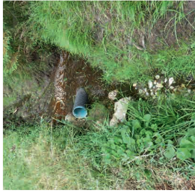
Neu drainagierter Randbereich
