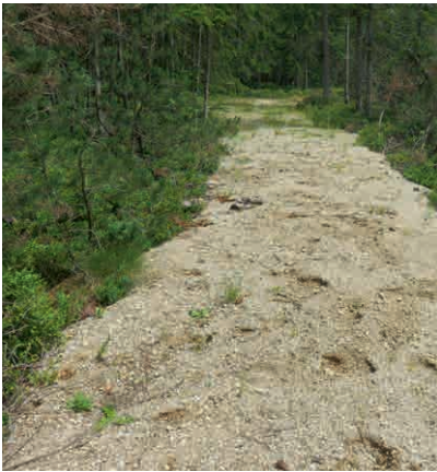
Neu geschotterte Forststrasse
